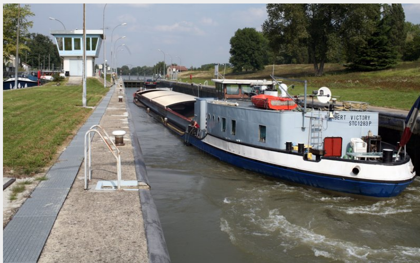
Écluse de Boran-sur-Oise (PNROPF)
